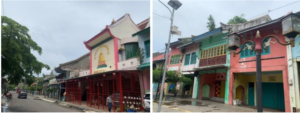
Gambar 12. Atap bangunan Kampung Cina Kota Bengkulu Sumber: Dokumentasi Pribadi, 2022
