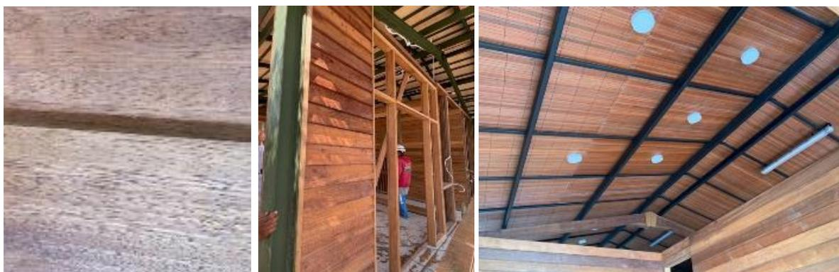
**Gambar 8. Dinding eksterior berbentuk tumpang tindih (A), Dinding interior berbentuk seperti *lambesering* (B), Plafond Krei kayu Bangkirai (C)**
