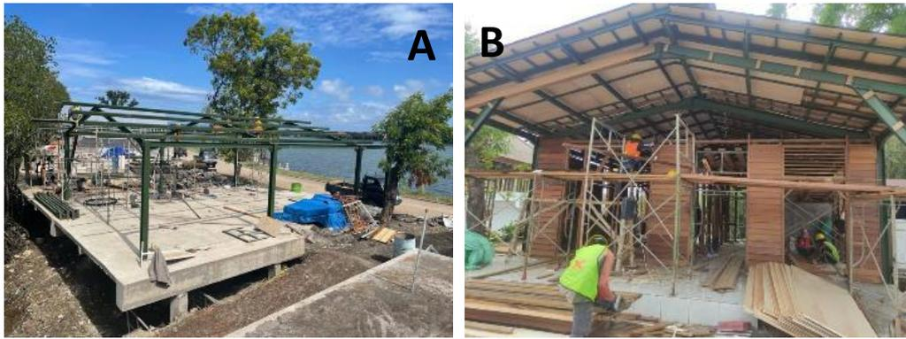
**Gambar 7. Penggunaan beton pracetak sebagai pondasi dan baja sebagai struktur utama kolom dan atap bangunan (A) Cover Kayu pada Material Baja (B)**
