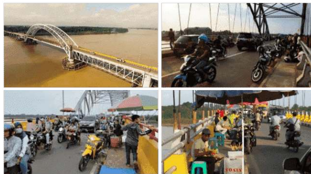
Gambar 27. Gambaran Jembatan Batanghari II Sumber: Data Olahan
