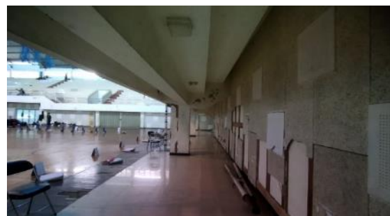
Gambar 7. Kondisi Interior Bangunan Sumber: Data dan Analisa Pribadi
