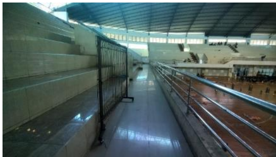
Gambar 4. Kondisi Interior Bangunan Sumber: Data dan Analisa Pribadi
