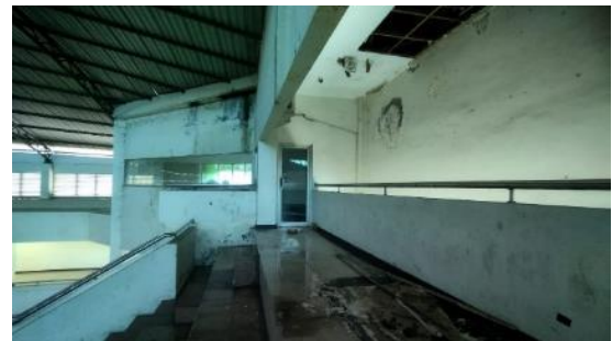
Gambar 5. Kondisi Interior Bangunan Sumber: Data dan Analisa Pribadi
