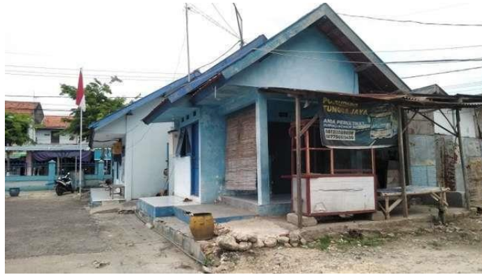
Gambar 7. Kantor terminal Sumber : Dokumen Pribadi
