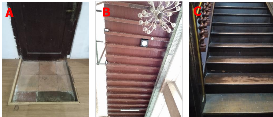
Gambar 4. Ekspose lantai asli (A), Plat lantai dan balok asli (B), Tangga yang telah mengalami penggantian material pada beberapa bagian (C) Sumber: Dokumentasi, 2021
