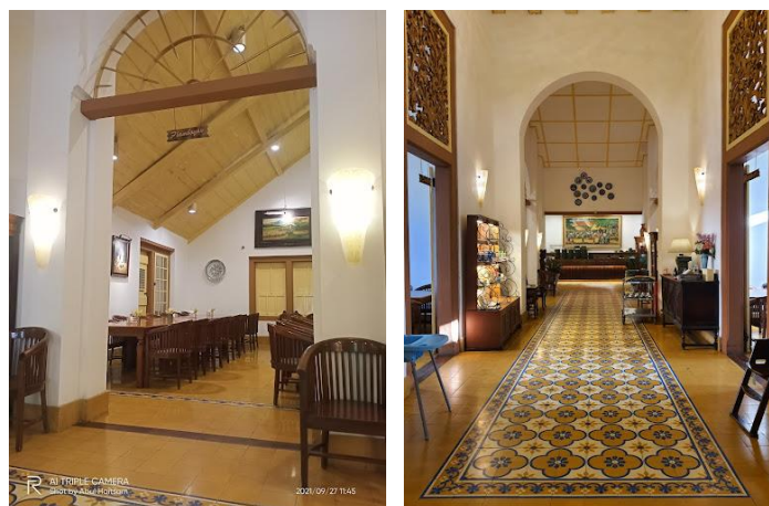
Gambar 6. Material kayu pada pintu, daun jendela, plafond (A) Material lantai teraso bermotif (B) Sumber: Dokumentasi penyusun, 2022
