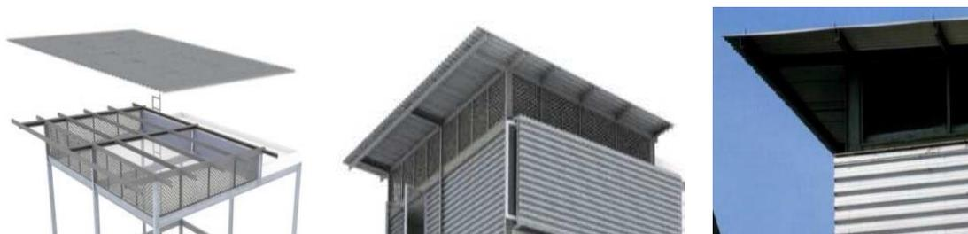
**Gambar 10.** Metal lembaran sebagai atap yang miring ke satu arah (timur lebih tinggi) yang diletakkan +/- 600 cm miring menjadi 400 mm, dari atas dinding, berfungsi sebagai bantalan/sirkulasi udara.
