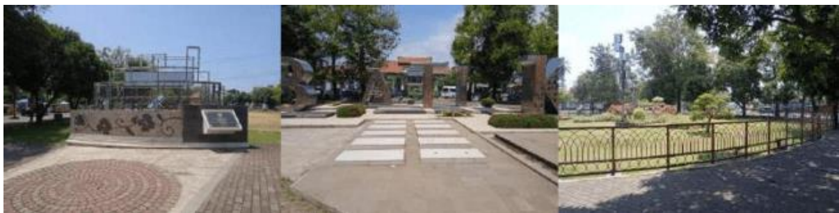
Gambar 2. Kondisi eksisting Taman Jetayu
