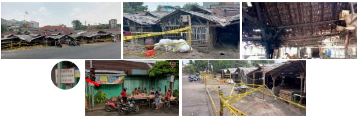
Gambar 2. Kondisi fisik Pasar Keputran Selatan (atas), Pemanfaatan jalan untuk berdagang (bawah) Sumber: Dokumentasi pribadi, 2023
