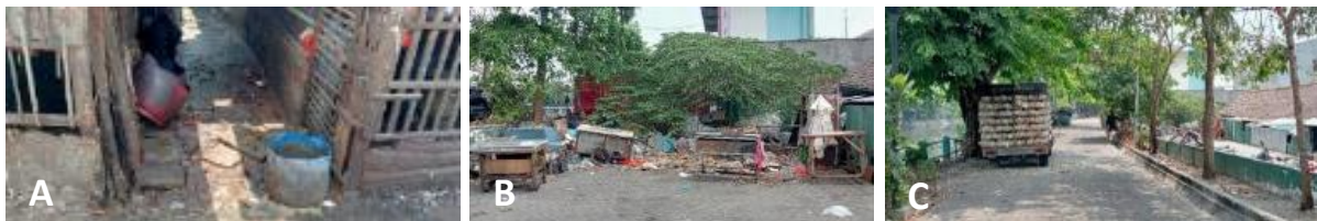
Gambar 3. Kondisi saluran drainase (a), kondisi tempat pembuangan sampah (b), pemanfaatan jalan untuk kegiatan bongkar muat barang (c)
