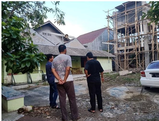
Gambar 1. Kondisi Eksisting Ruang Parkir Komunal
