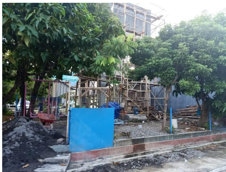
Gambar 2. Kondisi Eksisting Ruang Parkir Komunal
