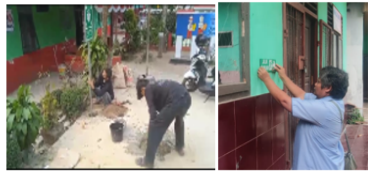
Gambar 6. Pemasangan jalur evakuasi Sumber: Penulis, 2024
