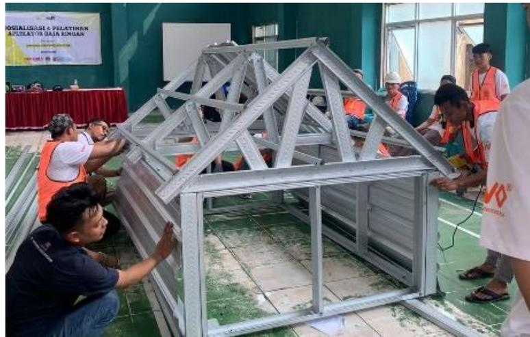
**Gambar 3. Praktek merakit struktur atap kuda-kuda baja ringan**
