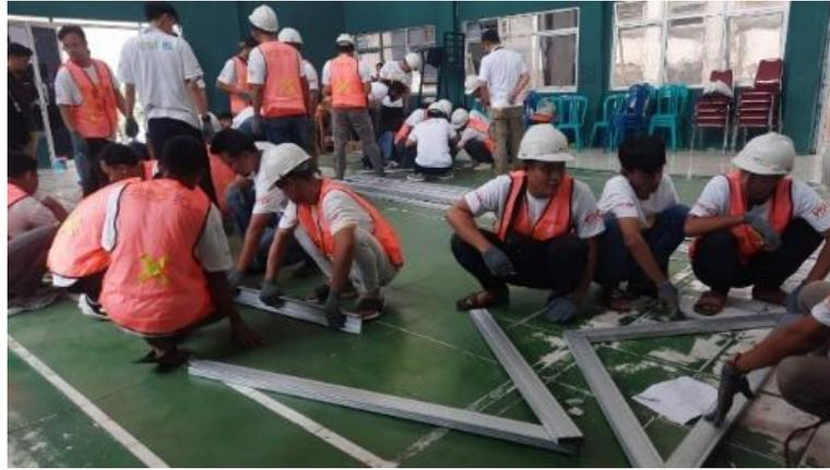
**Gambar 2. Praktek memotong dan menyambung produk baja ringan**
