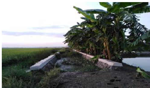
Gambar 2. Pembuangan Lumpur Bekas Kotoran Ikan Lele yang di Buang disaluran Drainase
