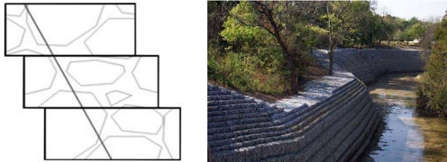
Gambar. 8. Contoh desain Revetment pada Sungai Asahan Hulu.
