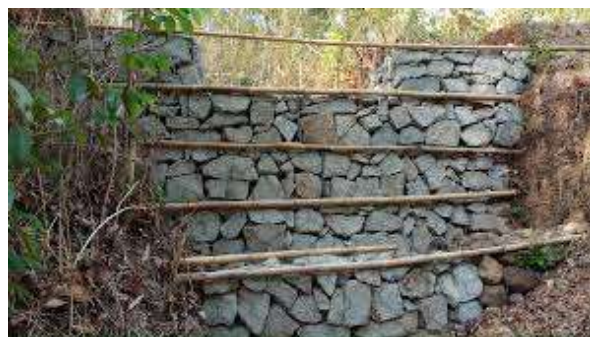
Gambar. 9. Contoh desain Gully Plug pada Sungai Asahan Hulu.
