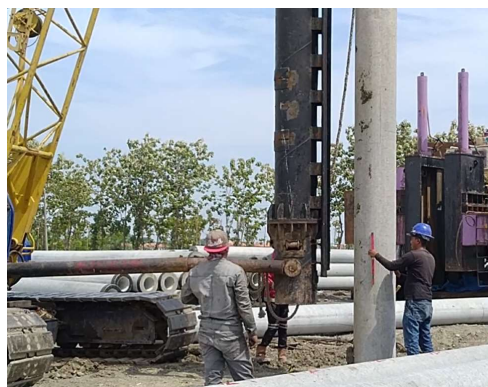
Gambar 2. Pengukuran Tegak Lurus Tiang (Verticalig).
