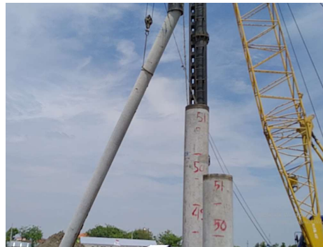
Gambar 1. Pengangkatan Tiang Pancang dan Penancangan.
