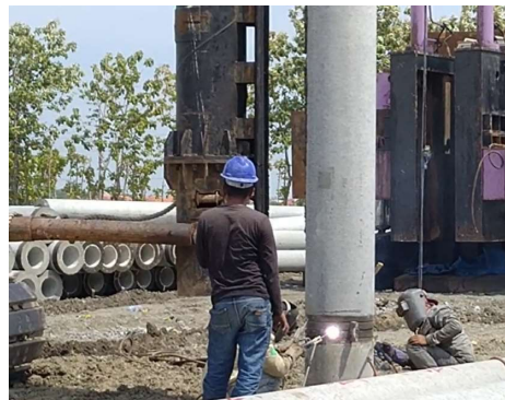
Gambar 4. Pengelasan Sambungan/Joint
