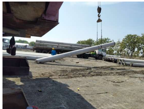
Gambar 6. Pengangkatan pancang dan Verticaling
