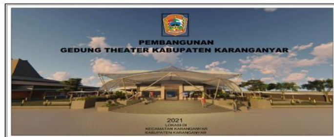
Gambar 1 Foto Fisik Gedung Teater Kabupaten.
