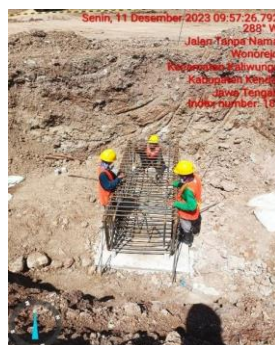
Gambar 4. 10 Pemasangan pembesian di tempat Pile Cap
