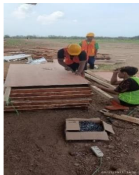
Gambar 4. 11 Fabrikasi bekisting
