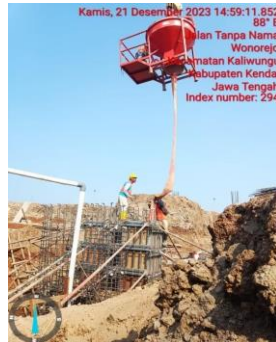
Gambar 4. 14 Pengecoran
