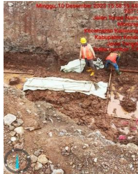
Gambar 4. 3 Proses pemasangan Plastik Cor
