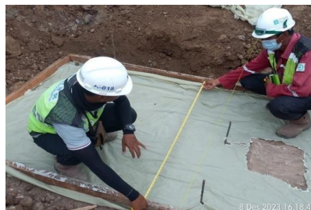
Gambar 4. 5 Pengecekan untuk pemasangan lean Concrete
