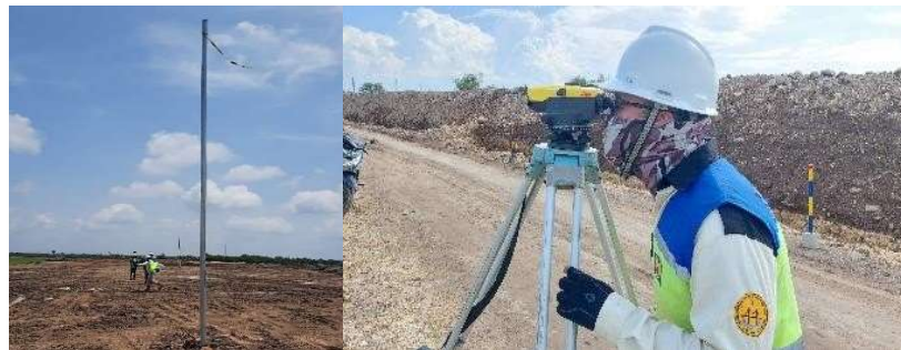
Gambar 6. Kegiatan Monitoring Penurunan Tanah dengan Settlement Plate
