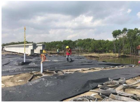
Gambar 11 : Proses pemasangan PHD , pasir dan Geotekstil non wuven
