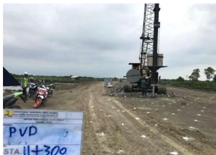
Gambar 10 : Proses pemasangan PVD
